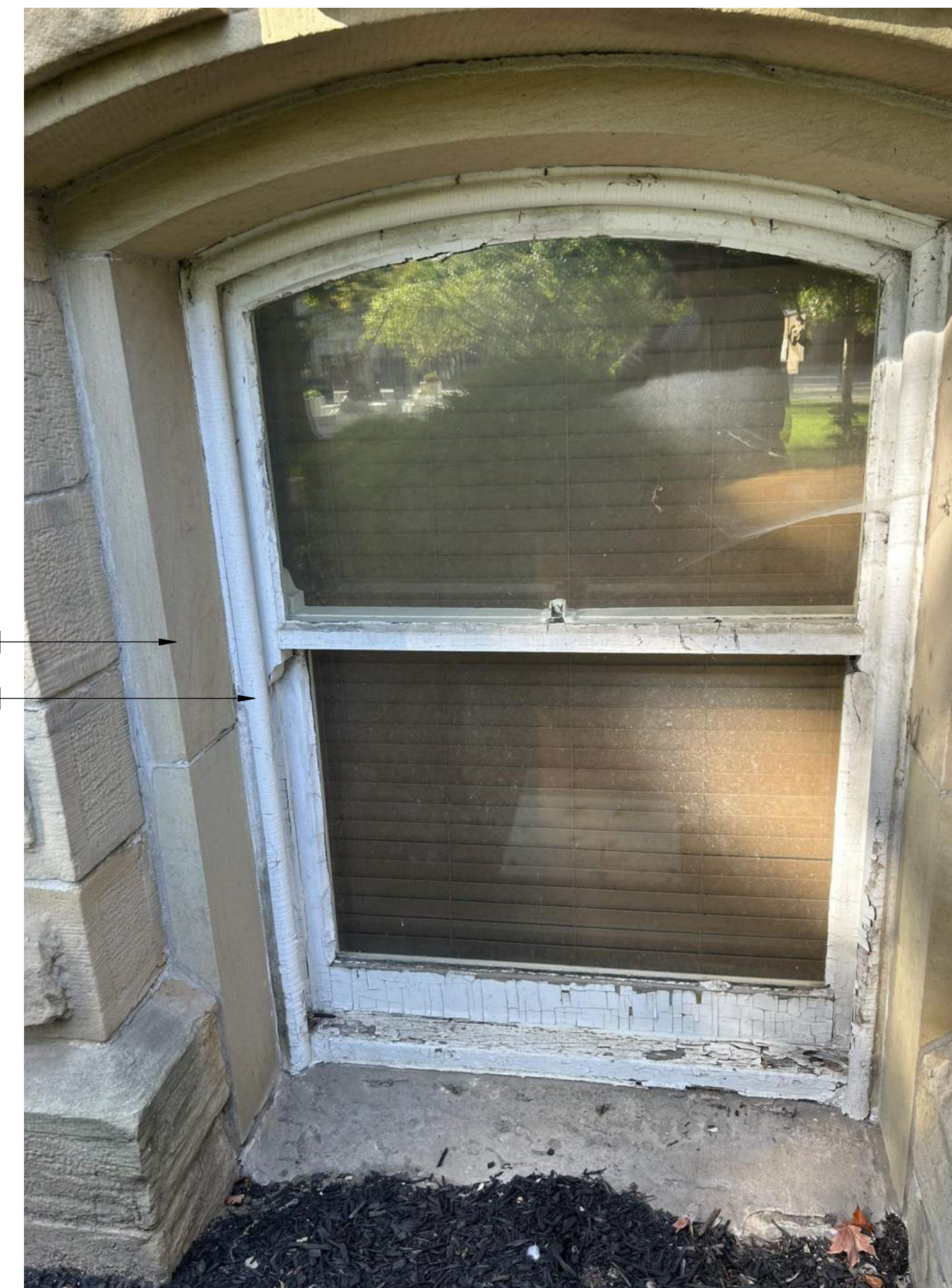
2 PHOTOGRAPH 1 - LOWER LEVEL SCALE: N.T.S.
