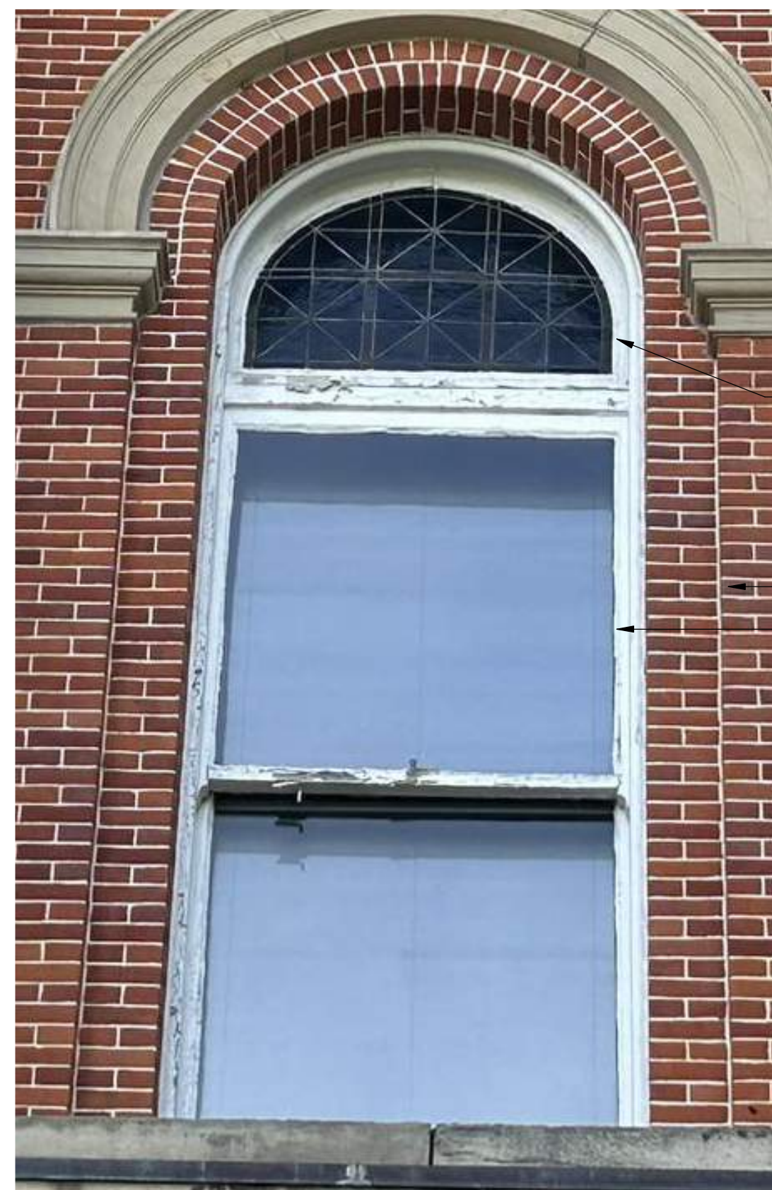
4 PHOTOGRAPH 3 - SECOND FLOOR SCALE: N.T.S.
