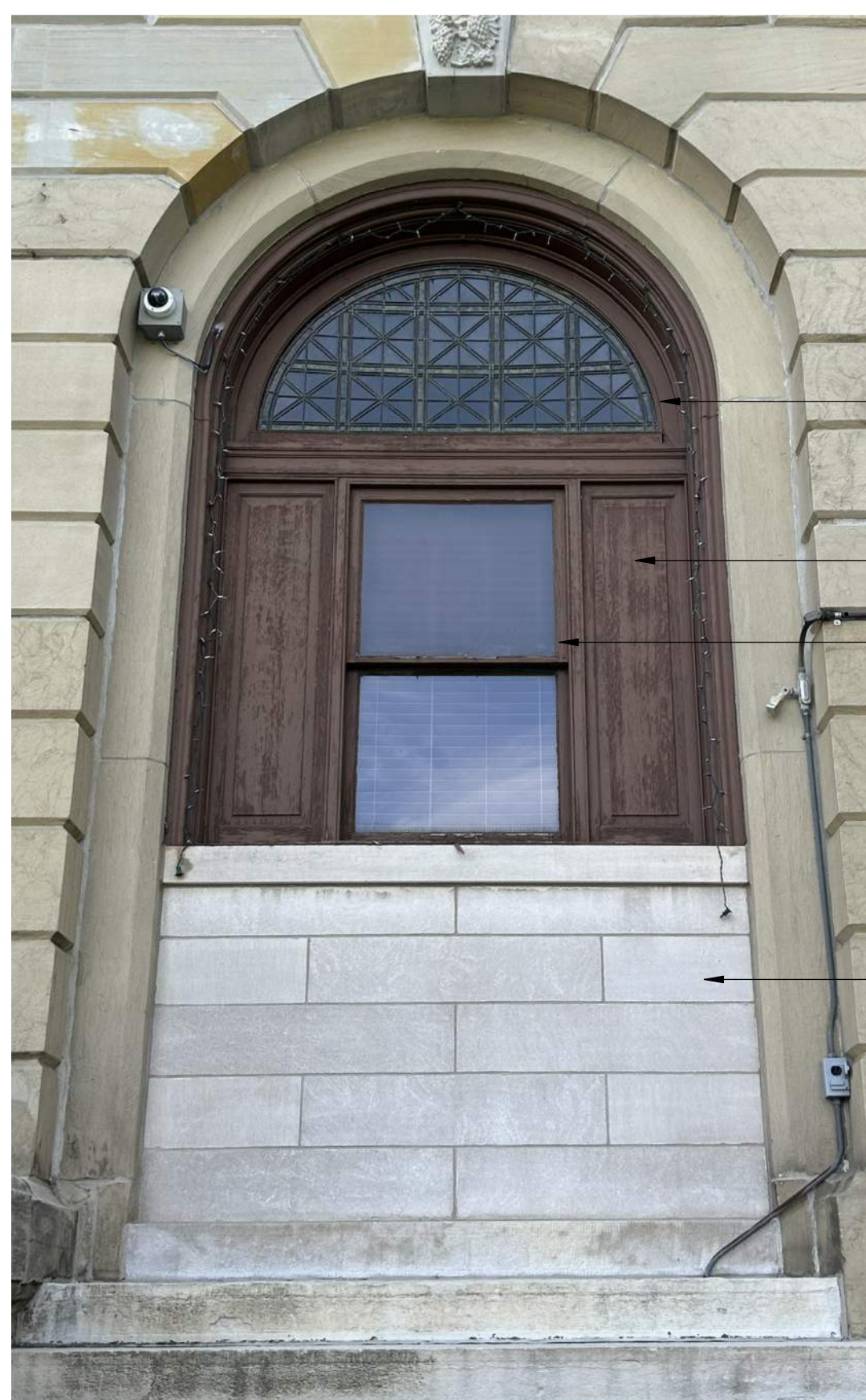
4 PHOTOGRAPH 3 - FIRST FLOOR SCALE: N.T.S.
