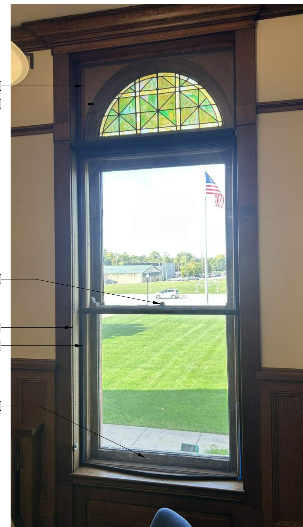
3 PHOTOGRAPH 2 - FIRST FLOOR SCALE: N.T.S.
