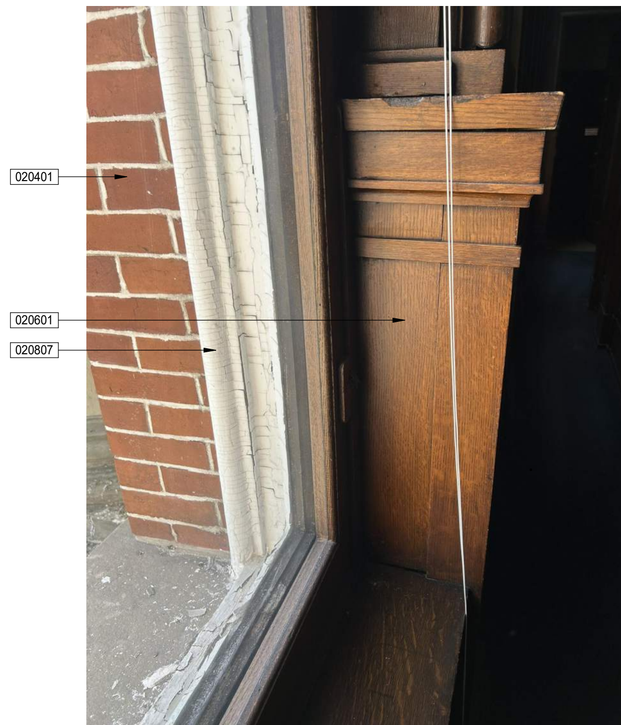
5 PHOTOGRAPH 4 - SECOND FLOOR SCALE: N.T.S.
