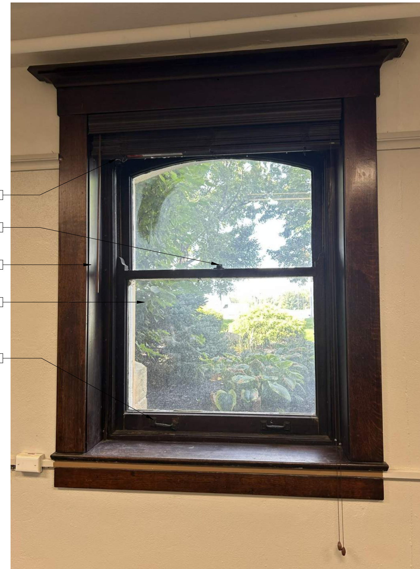
3 PHOTOGRAPH 2 - LOWER LEVEL SCALE: N.T.S.
